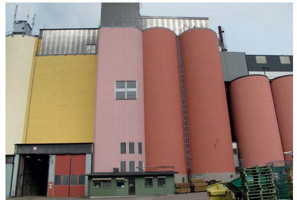
Silo i verksamhetsområde centralt i Grästorps tätort
